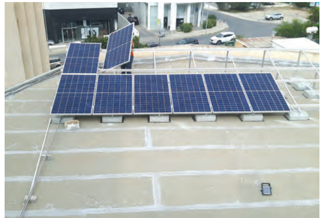
Εγκατάσταση φωτοβολταϊκών στο οίκημα
