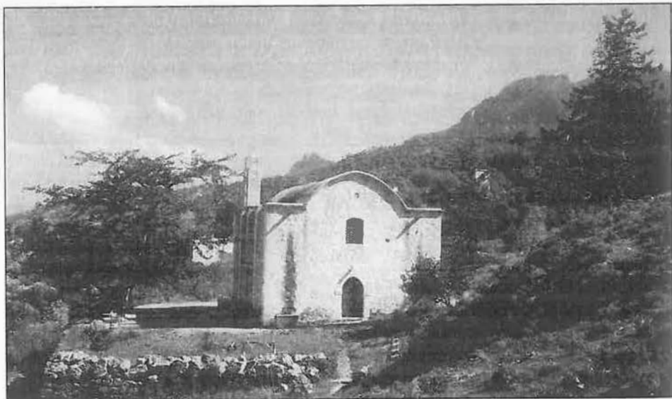
Η εκκλησία της Αγίας Ειρήνης - Δυτική πλευρά
