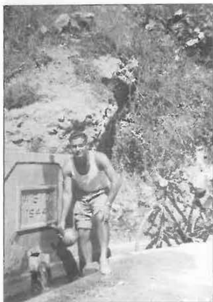
Η πηγή από τον καταρράκτη του Παλιόσοφου
