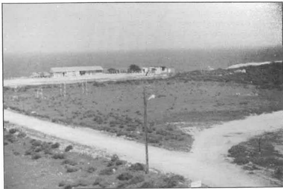
Νέες κτιριακές εγκαταστάσεις στην περιοχή της Λάμπουσας
