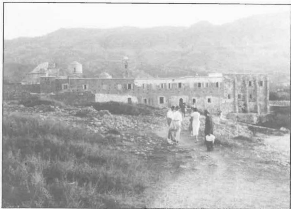
Το μοναστήρι της Αχειροποιήτου - (Βόρεια όψη) Φωτ. 1936
