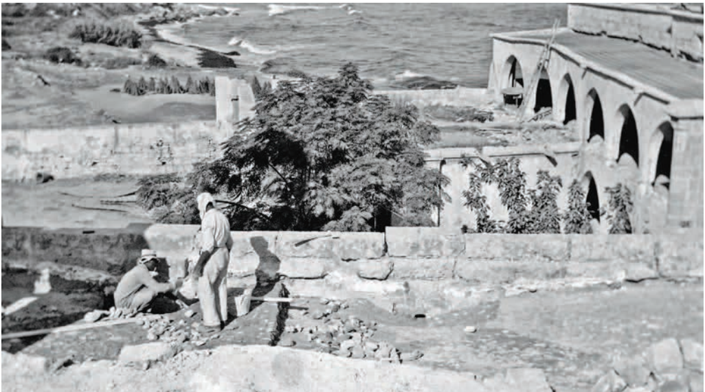
Επιδιόρθωση της νότιας πτέρυγας του μοναστηριού της Αχειροποιήτου, 1953
