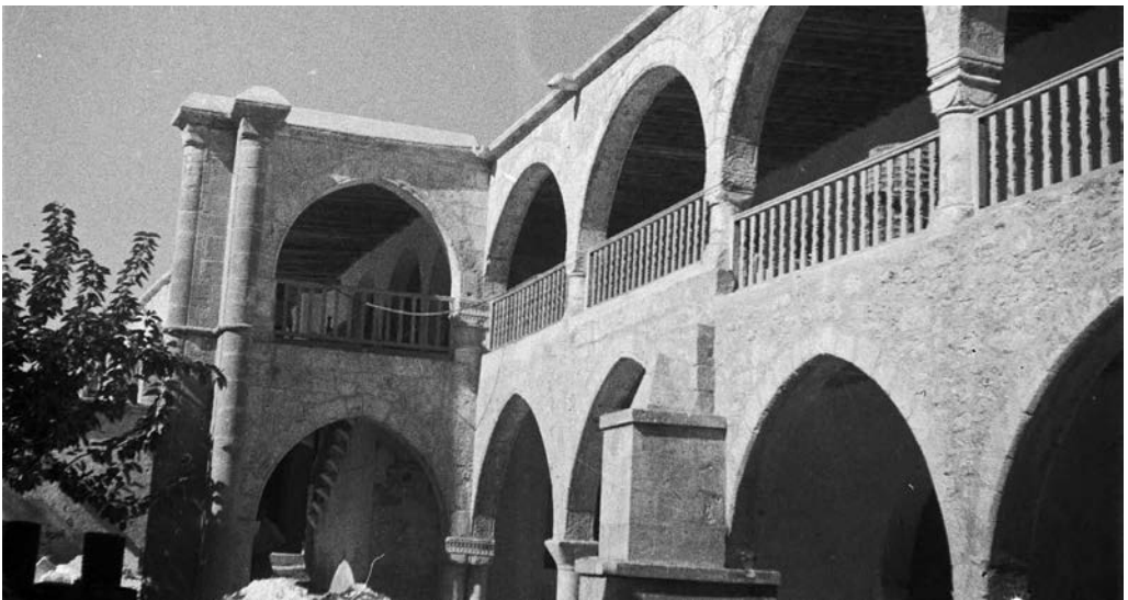
Τα κελλιά στη βόρεια πτέρυγα του μοναστηριού της Αχειροποιήτου
