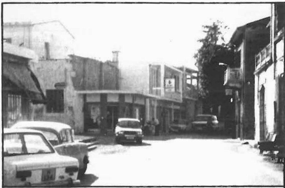
Κεντρική περιοχή του Καραβά (φωτ. Σεπτέμβρης 1988). Διακρίνεται το κτίριο που στεγαζόταν το σωματείο «ΑΡΗΣ» Καραβά πριν το 1974.
